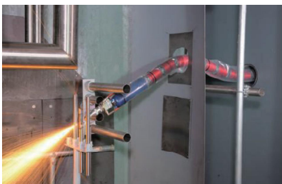
图 4 超冗余机器人切割/焊接作业
